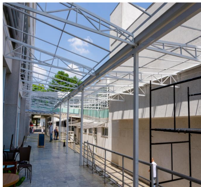
Ampliação da Cobertura entre os Prédios I e III, interligando os espaços, proporcionando maior conforto na circulação de pessoas
