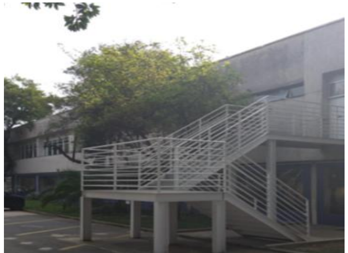
Escadas metálicas para rota de fuga
